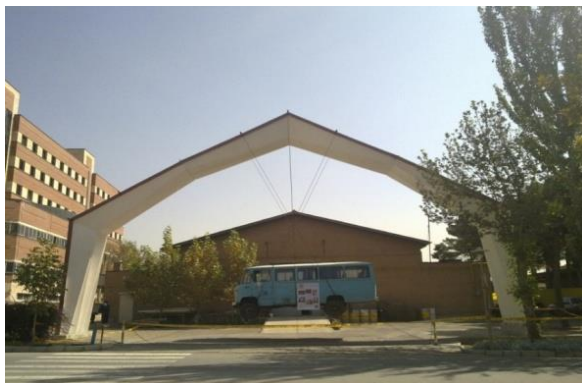
شکل ۱۹- نمونه واقعی سازه کامپوزیتی با صفحات تاشده
