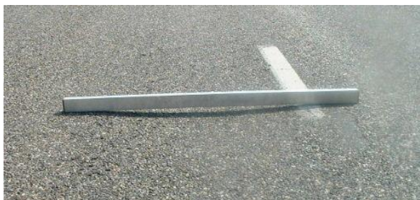
شکل ۲- شیارشدگی در بسترهای آسفالت
