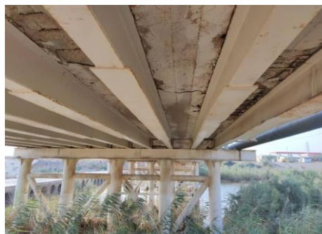
شکل ۷- نمایی از تیرهای فولادی فرعی و بادبندها
